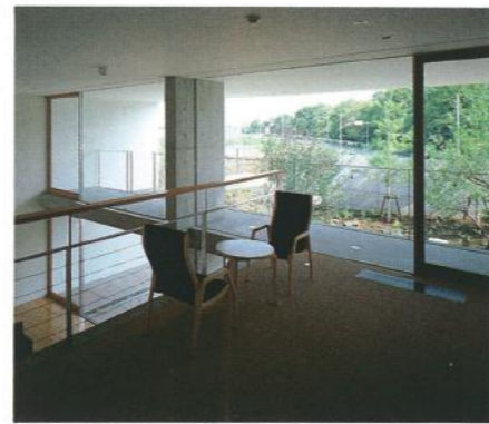
ラウンジ、開口部の方立はステンレス製。
