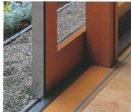
食堂開口部ディテール、木製サッシの外部側を耐候性のあるステンレスのムク材で覆う。方立は木製。
