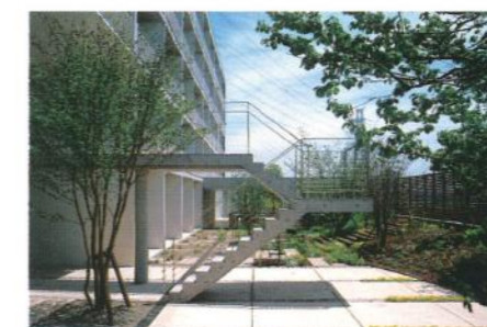
ロビーテラスの外部階段。
