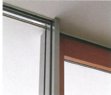
ラウンジ開口部、可動部の木製サッシは食堂と同じように外部側をステンレスムク材で覆う。方立は金属製。
