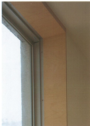
廊下の中庭側開口部枠回り。上部には30mm厚、側部には9mm厚のパーチ合板。
