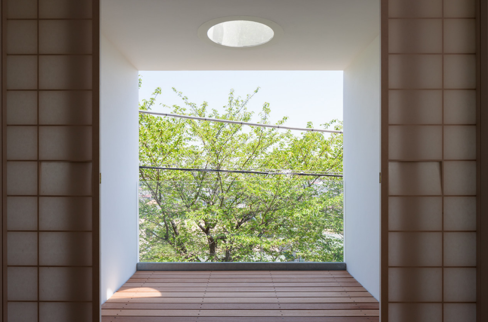
2階寝室からバルコニーを見る。強化ガラスの手摺りは外部の緑への景観を遮ることなく安全性を担保する。
