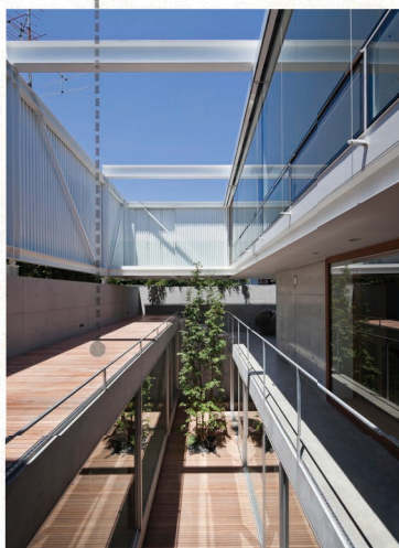
写真2 | 2階階段側からルーフトラスと中庭を見る
