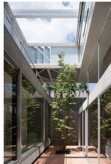
写真1 | 地階階段側から中庭を見る。左側が水廻り、右側が寝室。水廻り上部はルーフトラスのため、開放的な空間となっている
