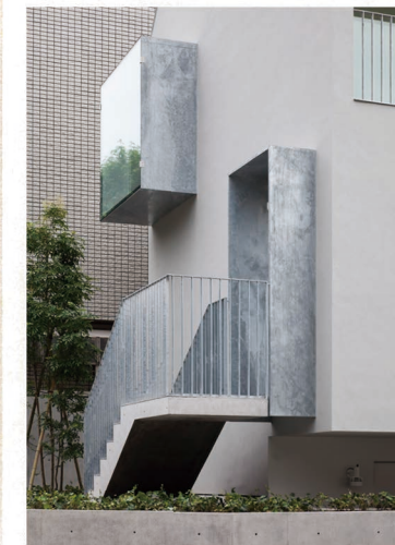
写真1 | 玄関廻り。溶融亜鉛めっきの素材感によって、玄関廻りと出窓、手摺のデザインがまとめられている
