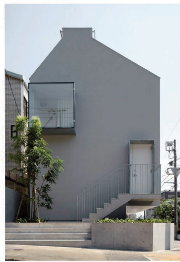
写真2 | 前面道路側から建物をみる。曲られた玄関と出窓は、形状は異なるものの、対に見える
