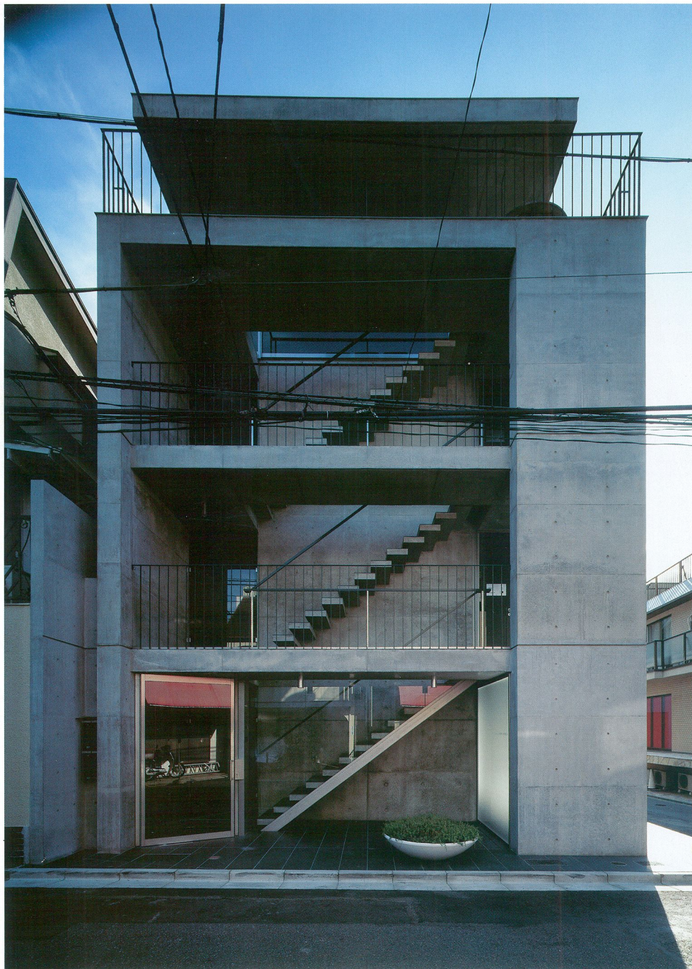
157頁：北側全景。「IL TEMPO (148-156頁)」と同様に北側のファサードはフルハイトのサッシュで覆われている。／上：東側外観。申請上、地下1階+地上3階となる。1階から3階は1フロア1住戸の集合住宅。
