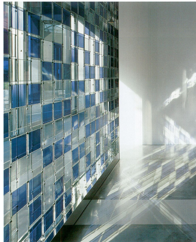
GALLERY KWONのパーティション。パネル自体がゆっくり色を変え外光を透過させて床や壁にパターンを映し出す。
