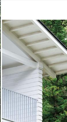
左：南東から見る。右：軒桁と屋根架構の接合部の近景。屋根ト拉斯は剛接合（軒桁・柱仕口詳細図参照）にして現しとし、柱に対し軒筋を柱の上に載るように見せている。
