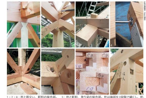
1・2・8：柱と筋交い、軒桁の接合部。3：柱と軒桁、登り梁の接合部。柱は端部を2段階で細くし、軒木を貫いている。4：星形の金物、ジベル。5・6：土台と柱、筋交いの接合部。7：仕上加工。
