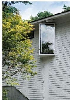
前面道路に直交する出窓の近景。ガラス窓はサッシレスのシールジョイントによるフィックスとし、背面に通気用の開口を設置。
